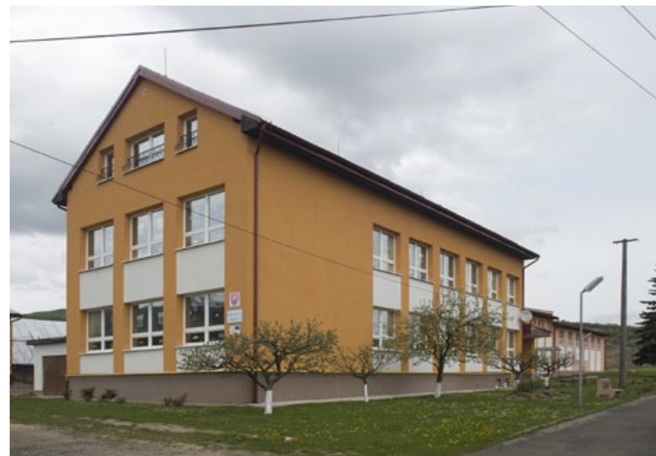
Základná škola po rekonštrukcii (rok 2010)
